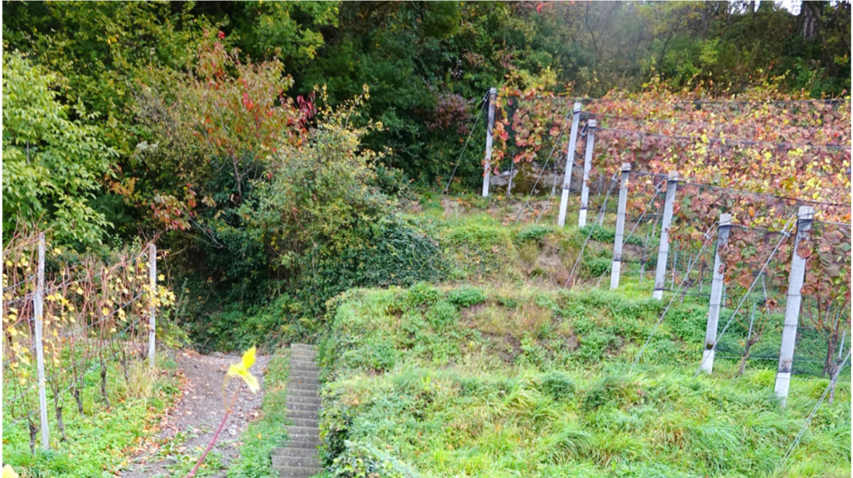
Abb. 3: Ausgangszustand. Die Reste der Trockenmauer 11b befinden sich in der Bildmitte oberhalb der Treppe und sind durch Gehölze verdeckt.
