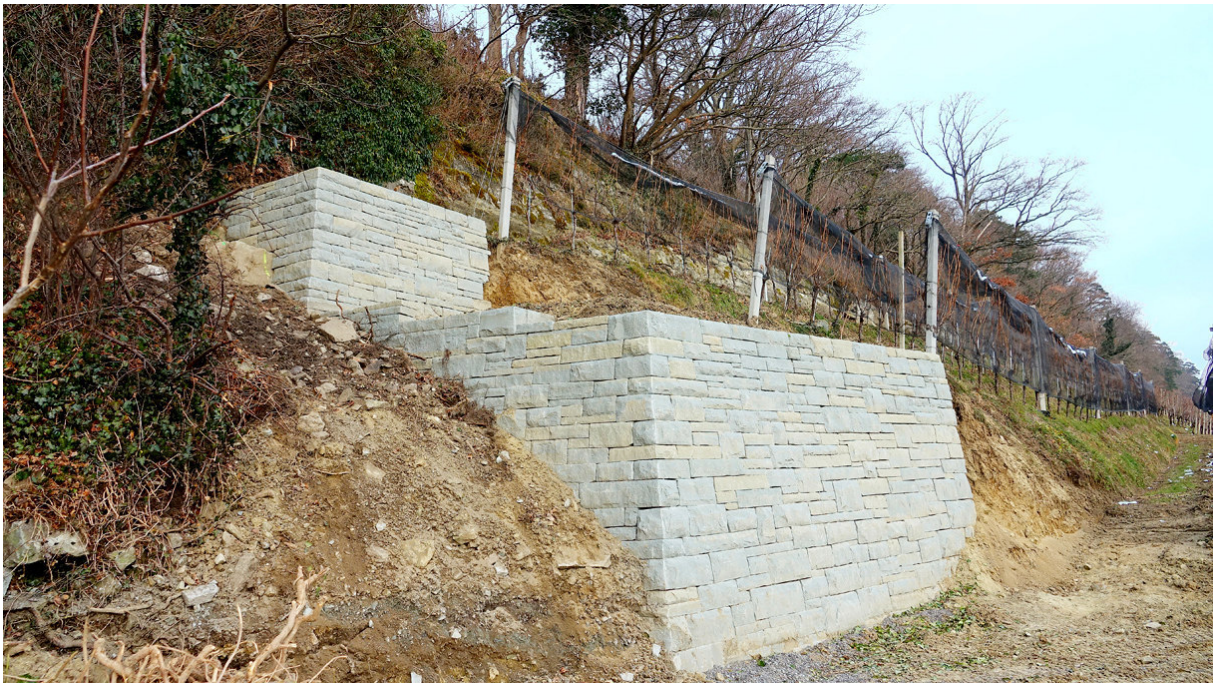
Abb. 4: Trockenmauer 11b nach der Sanierung. Aus Stabilitätsgründen und um eine ausreichende Hintermauerung mit Schroppen zu ermöglichen, wurden Seitenflügel gebaut.
