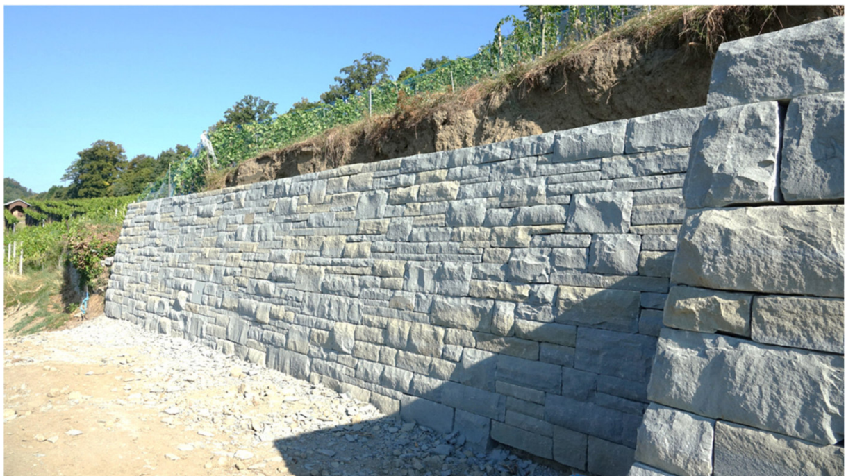
Abb. 10: Trockenmauer 14b nach der Sanierung. Im Bildvordergrund rechts ist die Ecke der Mauer 14 zu erkennen.
