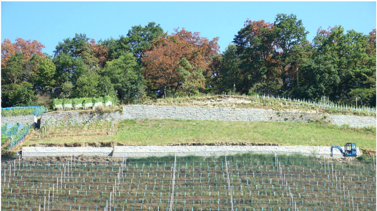
Abb. 8: Trockenmauer 14 nach der Sanierung (im Bildvordergrund, auf der Terasse mit dem Kleinbagger). Etwas nach hinten versetzt schliesst links die Trockenmauer 14b an.
