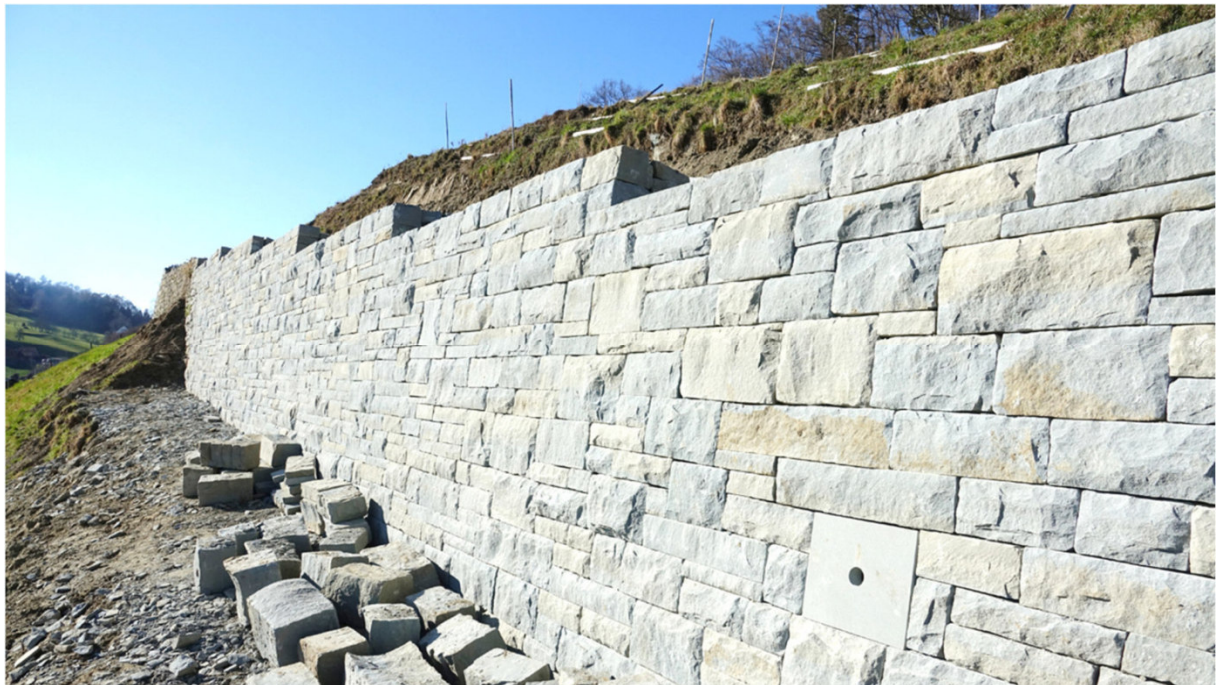
Abb. 6: Trockenmauer 17 nach der Sanierung. Im rechten Bildvordergrund ist das Einflugloch für den Wiedehopf zu erkennen.
