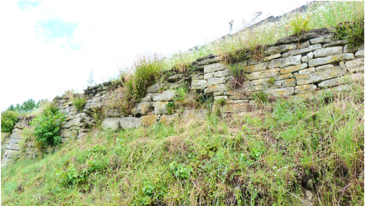
Abb. 7: Ausgangszustand. Die Mauer wurde von Lockermaterial überrieselt, das sich am Mauerfuss ansammelte. Um für Hintermauerung und Aushub Platz zu schaffen, wurde die Mauer wenige Meter nach unten versetzt.
