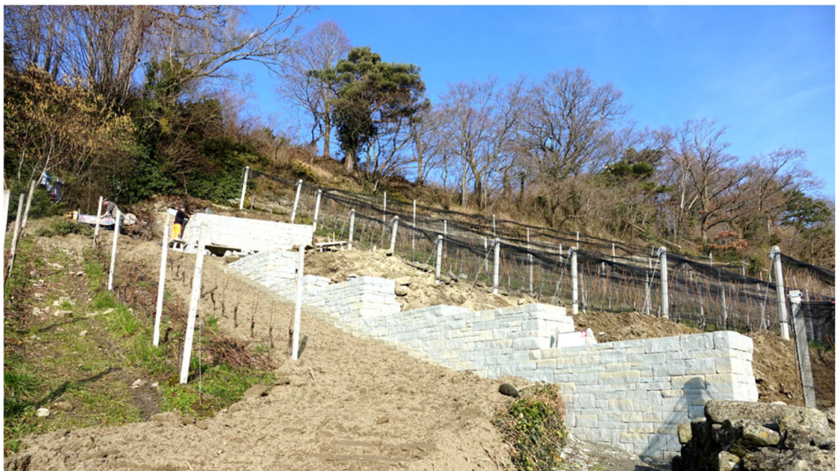
Abb. 2: Trockenmauer 11 nach der Sanierung. Die Sanierungsarbeiten an Trockenmauer 11b (Bildhintergrund) sind noch im Gange.
